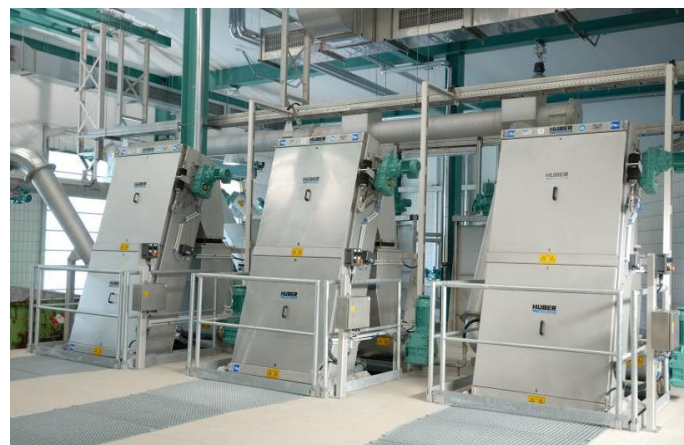
Parallele RakeMax®- Installation auf kommunaler Kläranlage
