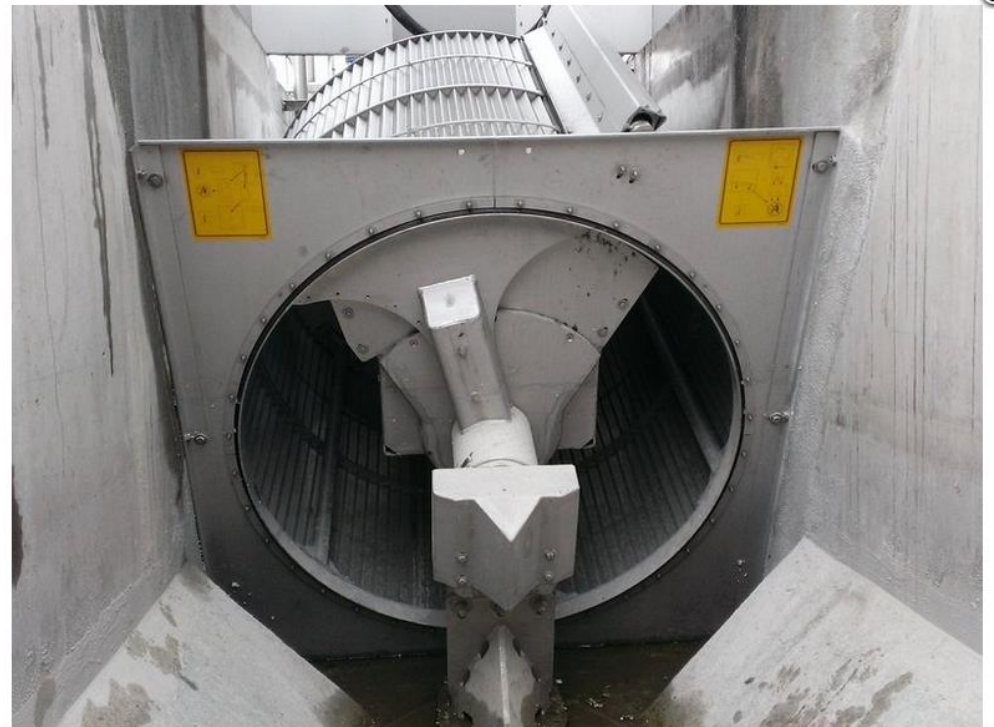
Tamiseur ROTAMAT® Star liquid HUBER, maille 1,5 mm, pour une protection efficace des membranes installées en aval
