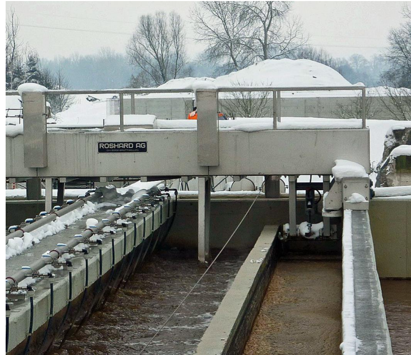
racleur à pont avec entraînement à câble
